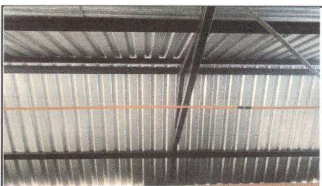
Foto 5: Sustrucción de Lámina y Capotes
