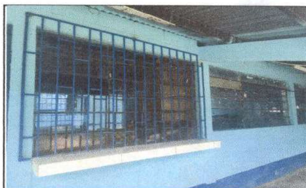
Foto 4: Sustrucción de Vidrios y de balcones
