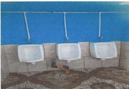
Foto 5: Sustitución de Mingitorio
