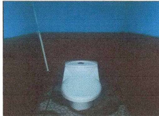
Foto 4: Sustitución de Inodoro
