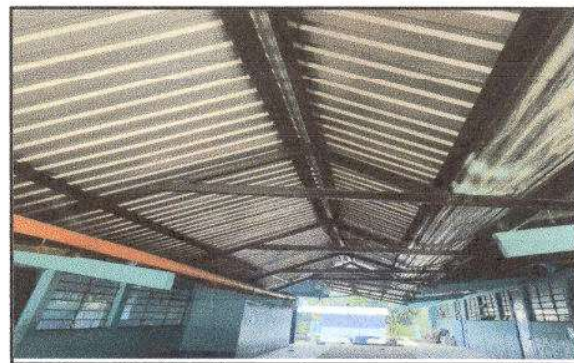
Foto 6: Sustitución de Lamina
