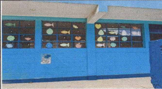
Foto 1: Sustitución de vidrios
