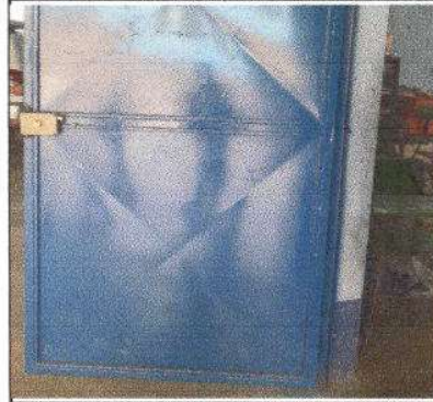
Foto 2: Sustitución de Chapa
