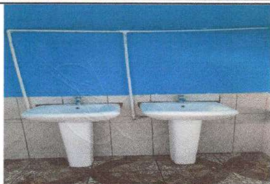
Foto 1: Sustrucción de Pared
